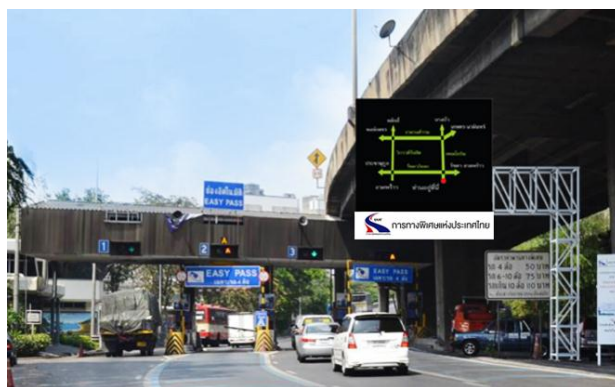
โครงการ Gateway Billboard Phase 2
